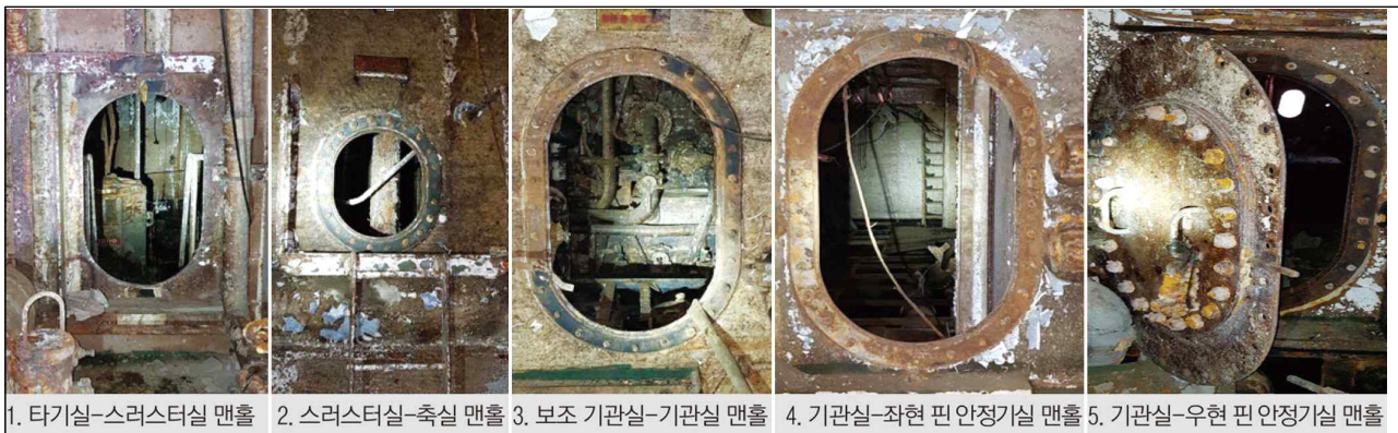
[사진 6] D갑판 하부 구획 간 맨홀 개방상태(선조위 보고서)
