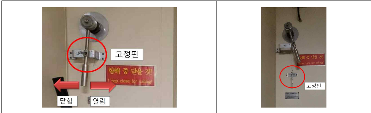
<그림 10> 고정핀을 꽂은 상태(좌), 고정핀을 뺀 상태(우)
