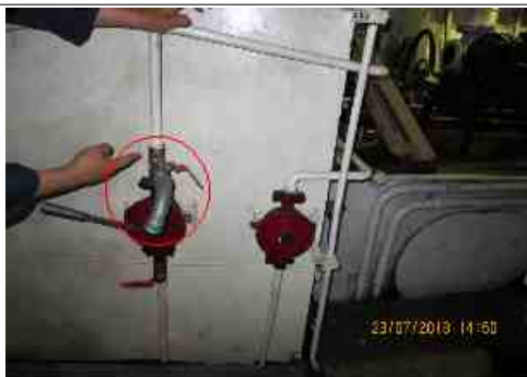
[사진 2] 핸드펌프 위에 설치된 드레인 샘플링 채취 밸브
