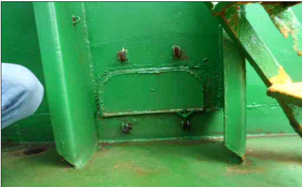
[사진 6] 사고 이후 용접으로 완전히 밀폐시킨 상태의 방수구
