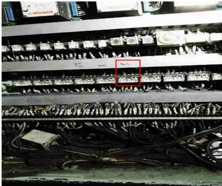
[그림 5] 주기판 배전반 내부 모습(후진 릴레이 교체)
