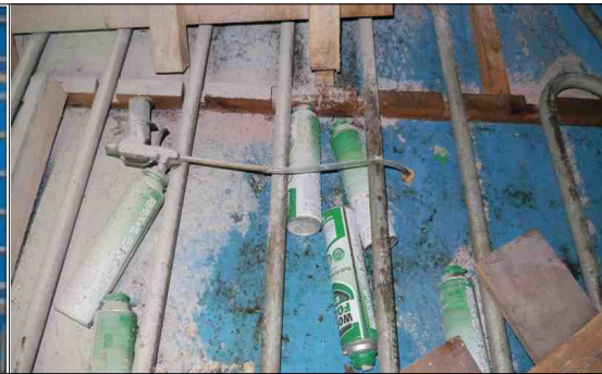
[그림 3] 에어건에 우레탄 폼을 연결한 모습
