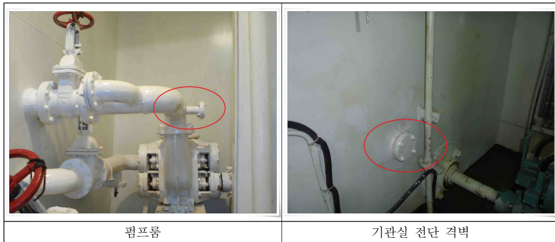
[사진 1] ②번 화물유펌프 토출라인에 설치되었던 배관(50A: 기관실 유도)
