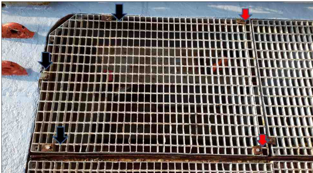
[그림1] 발판. 사고 이전에는 우측 상하의 2개소에만 볼트-너트가 채워져 있었음
