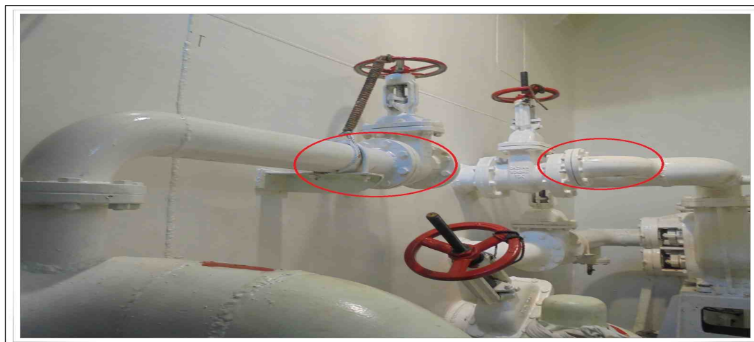
[사진 2] 펌프 룸 내 ①, ②번 화물유 펌프 토출라인 연결 배관(80A)
