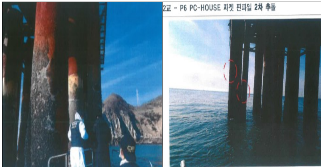
[그림 11] 사고발생 교각공사시설 접촉부위(왼쪽이 희생강관, 오른쪽이 자켓핀파일)
